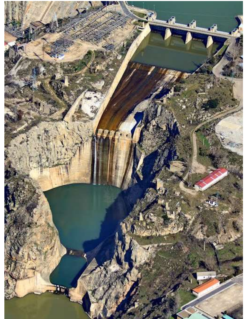
Figura 12. Fotografía aérea de las compuertas y aliviadero de la Presa de Ricobayo. Foto: megaconstrucciones.net
