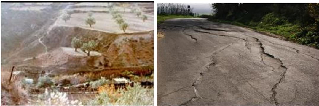
Figura 1. Deslizamientos rotacionales asociados a las margas azules con alto contenido en esmectitas. a) En el pueblo de Olivares; b) afectando a la carretera de Carmona.
